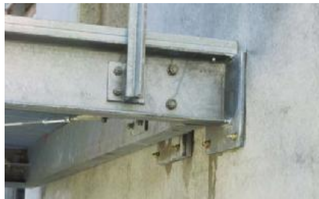
Резьбовая шпилька VA-A fvz обладает высокой коррозионной стойкостью (горячее цинкование)
